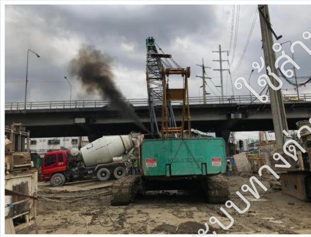
ภาพตัวอย่างมลสารทางอากาศจากเครื่องจักรกล
